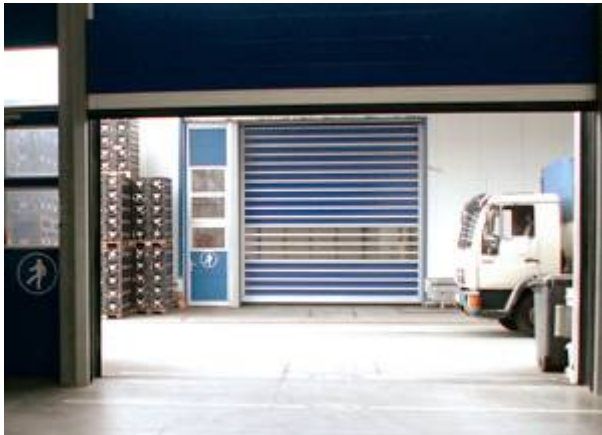
Rolltor mit Schaltleiste in der Hauptschließkante und einstrahliger Lichtschranke in ca. 0,40 m Höhe über dem Boden
